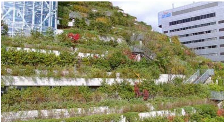
In de Japanse stad Fukuoka (300.000 inwoners) staat een innovatief ontworpen gebouw met groene terrassen, dat van buiten ogt als een groene oase. Binnen bevinden zich een concertzaal, conferentiezaal, kantoren en winkels. 59 / 60
